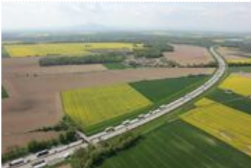
Autostrada A4 - widok z lotu ptaka
