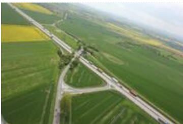
Autostrada A4 - widok z lotu ptaka
