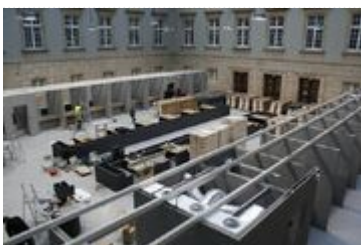
Budowa nowoczesnej Sali Obsługi Klienta na dziedzińcu wewnętrznym DUW - postępy prac
