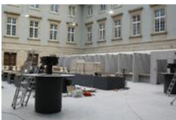
Budowa nowoczesnej Sali Obsługi Klienta na
