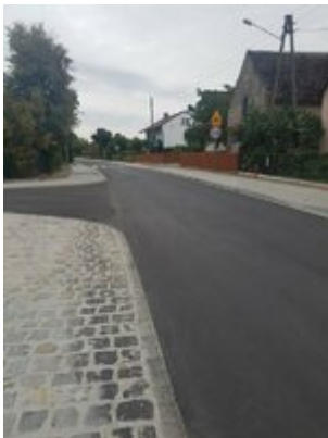
Otwarcie nowo przebudowanej drogi w Malerzowie
