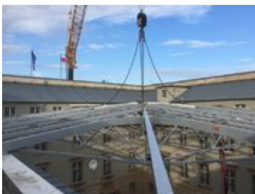
Montaż konstrukcji zadaszenia na dziedzińcu wewnętrznym DUW
