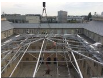
Konstrukcja zadaszenia atrium
