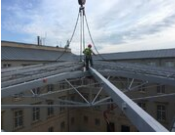
Montaż konstrukcji zadaszenia
