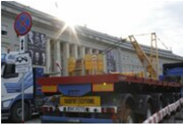
Przygotowania do kolejnego etapu przebudowy
