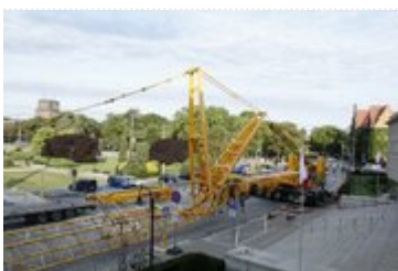
Przygotowania do kolejnego etapu przebudowy
