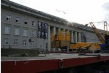
Przygotowania do kolejnego etapu przebudowy
