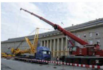
Przebudowa dziedzińca wewnętrznego DUW
