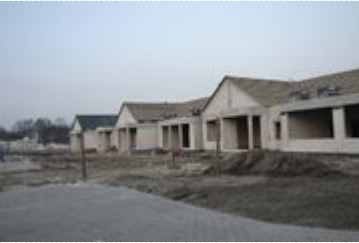
Budowa oddziału szkolnego
