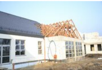
Budowa Zespołu Szkolno-Przedszkolnego w Dobrzykowicach
