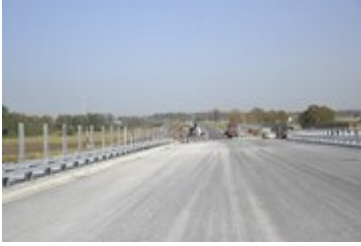
Dolnośląski odcinek drogi ekspresowej s5
