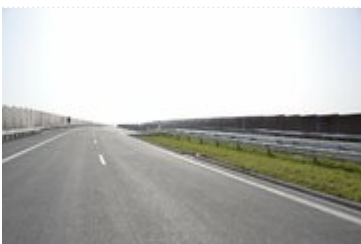
Dolnośląski odcinek drogi ekspresowej s5
