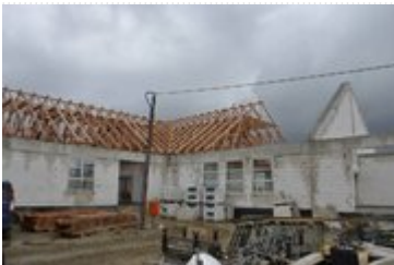
Budowa zespołu szkolno-przedszkolnego w Dobrzykowicach
