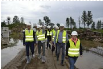
Wojewoda Dolnośląski wizytuje budowę inwestycji w Dobrzykowicach
