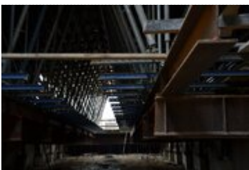
Konstrukcja mostu MS41
