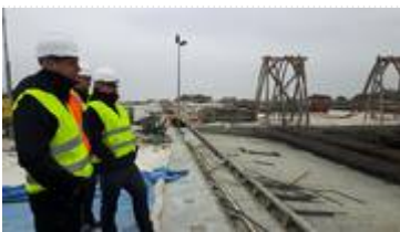
Wojewoda Dolnośląski na placu budowy
