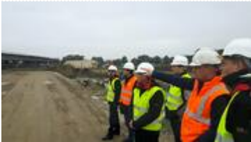
Wojewoda monitoruje proces nasuwania mostu na Widawie
