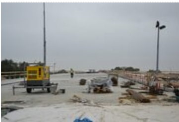
Budowa mostu MS 41
